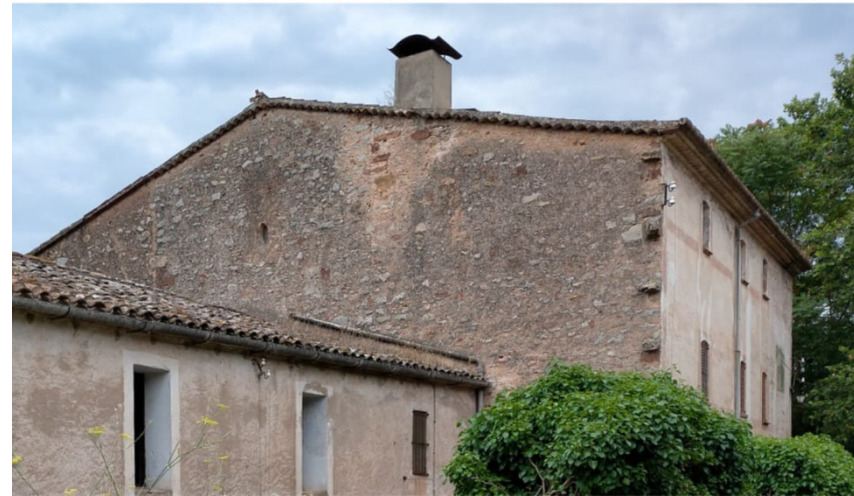
Can Térmens (façana lateral)
