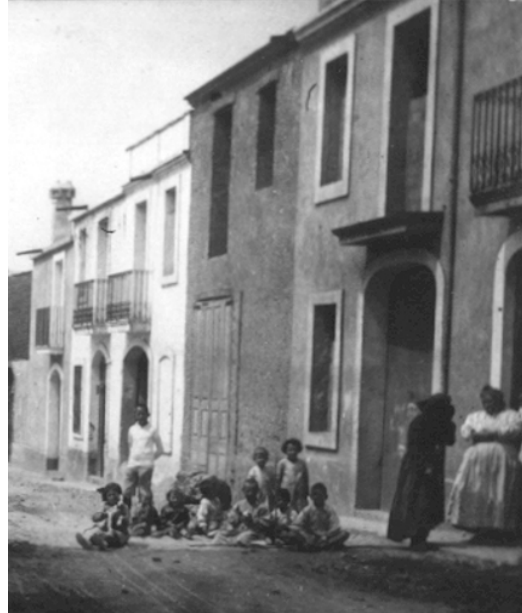
Façanes arrebossades amb emmarcat (Carrer Major)
