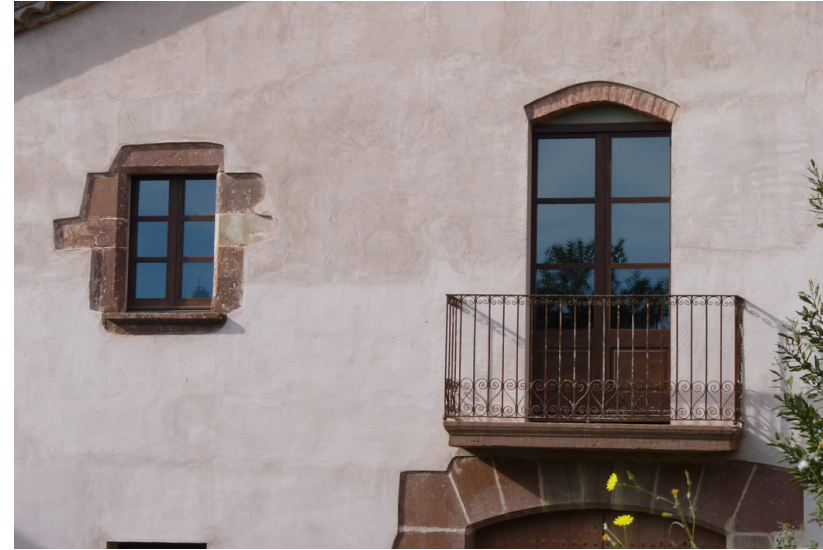
Can Vendrell, destrucció finestra prèvia
