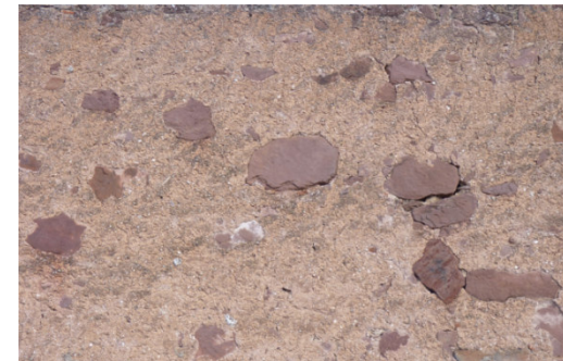
Escardejat de junta plena (revestiment pobre)
